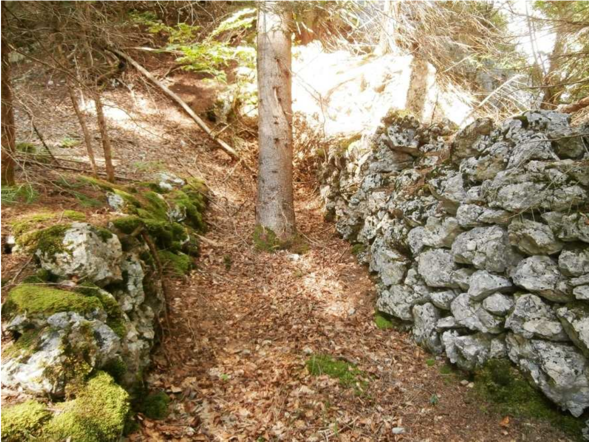
Mauerreste im Bereich B im östlichen Teil des Bergbaugebietes Knappenkögerl, Bereich Lauferwald-5. Möglicherweise schützen diese Mauern einen Stollenzugang. 5.9.2021.
